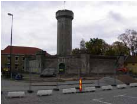
Vattenborgen, ombyggnad pågår
